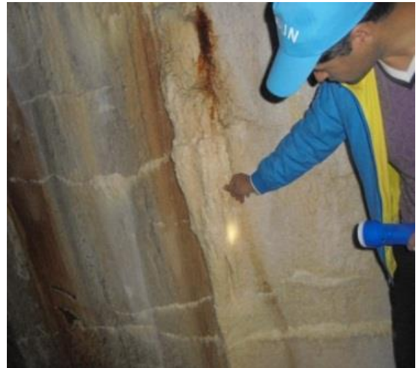
Расмҳои 2.3. Вайроншавиҳо дар қисми поёнии деворҳо, фарш ва қисми аркаи нақби №2.
