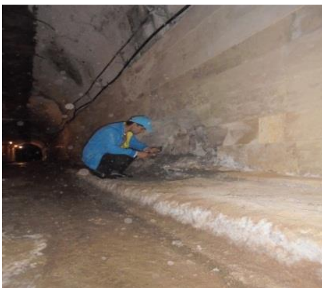
Расми 2.2а. Вайроншавии бетон дар қисмати девор ва аркаи нақби №3.
