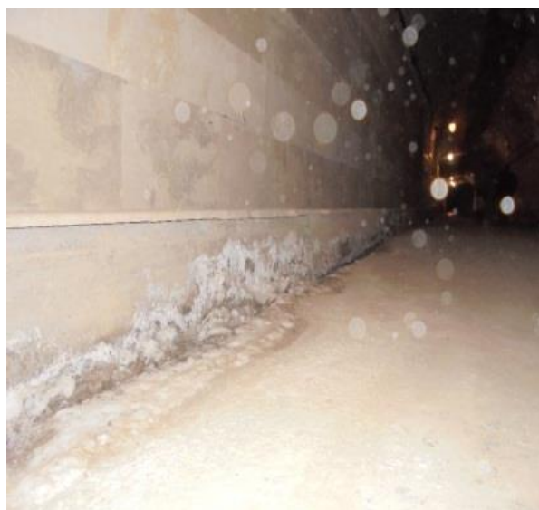
Расми 2.2а. Вайроншавии бетон дар қисмати девор ва аркаи нақби №3.
