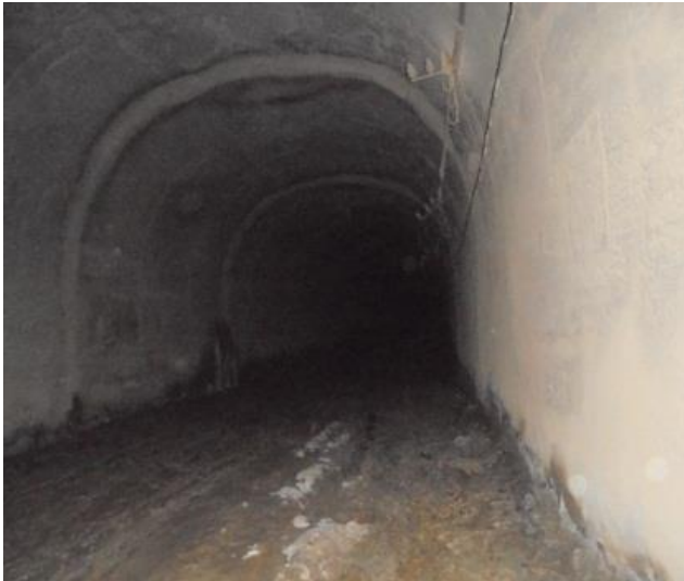
Расмҳои 2.3. Вайроншавиҳо дар қисми поёнии деворҳо, фарш ва қисми аркаи нақби №2.
