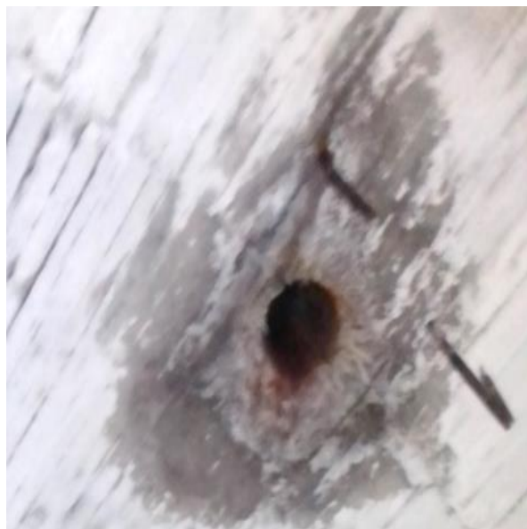
Расми 2.4 а. Вайроншавии бетон дар қисмати девор ва аркаи нақби №2
