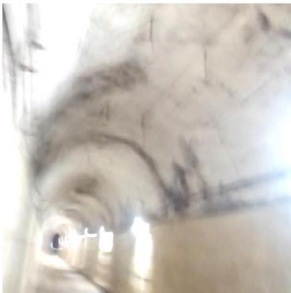
Расми 2.4 а. Вайроншавии бетон дар қисмати девор ва аркаи нақби №2
