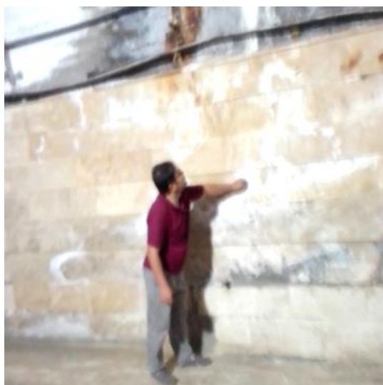
Расми 2.3. Вайроншавии бетон дар қисмати девор ва аркаи нақби №3
