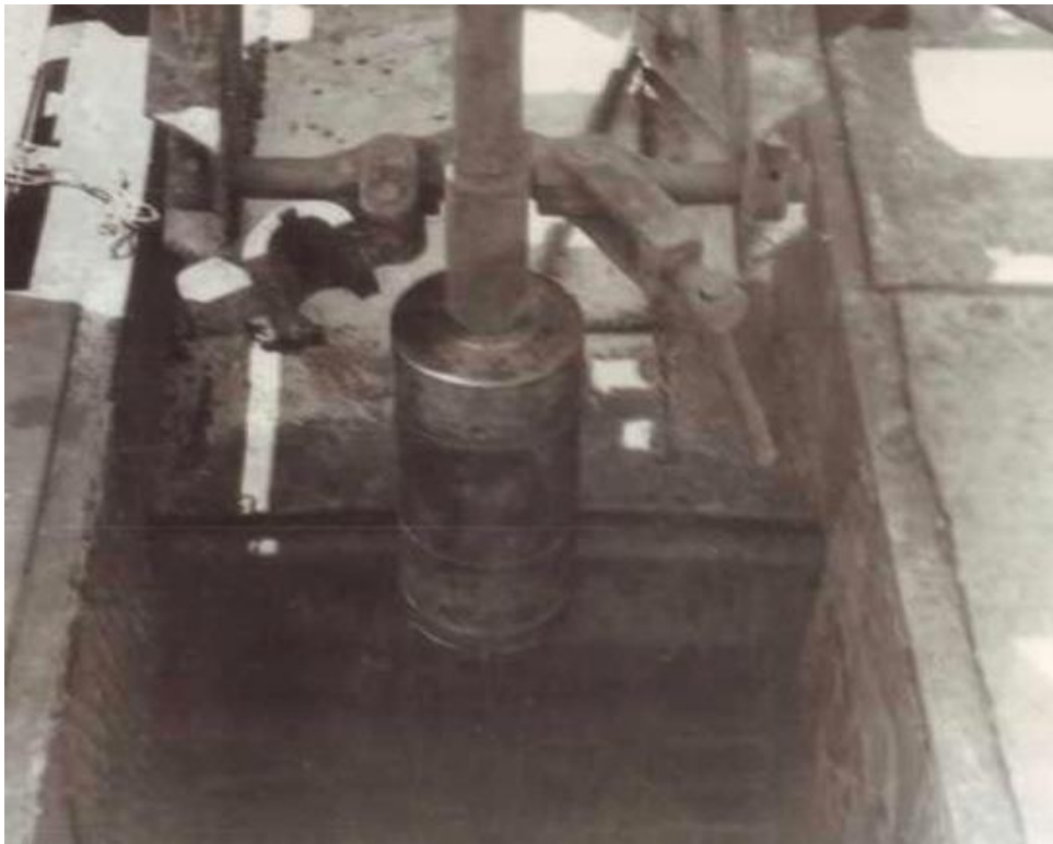
Рисунок 2.6. - Грунтоотборник перед погружением в забой скважины
