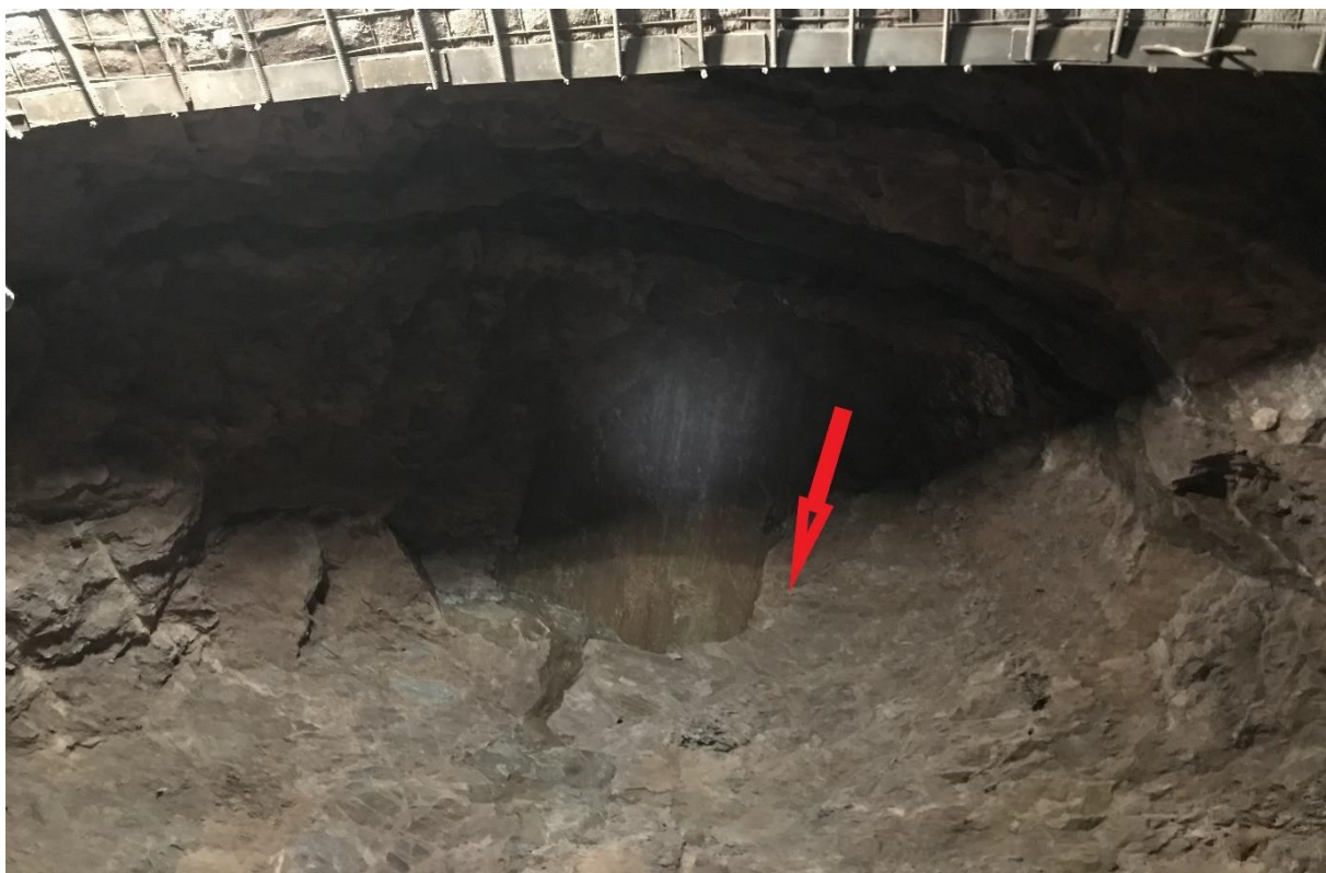
Рисунок 2.23: Разлом 35 в тоннеле СТ4-А, красной стрелкой показано направление зеркальных скольжений на плоскости разлома
