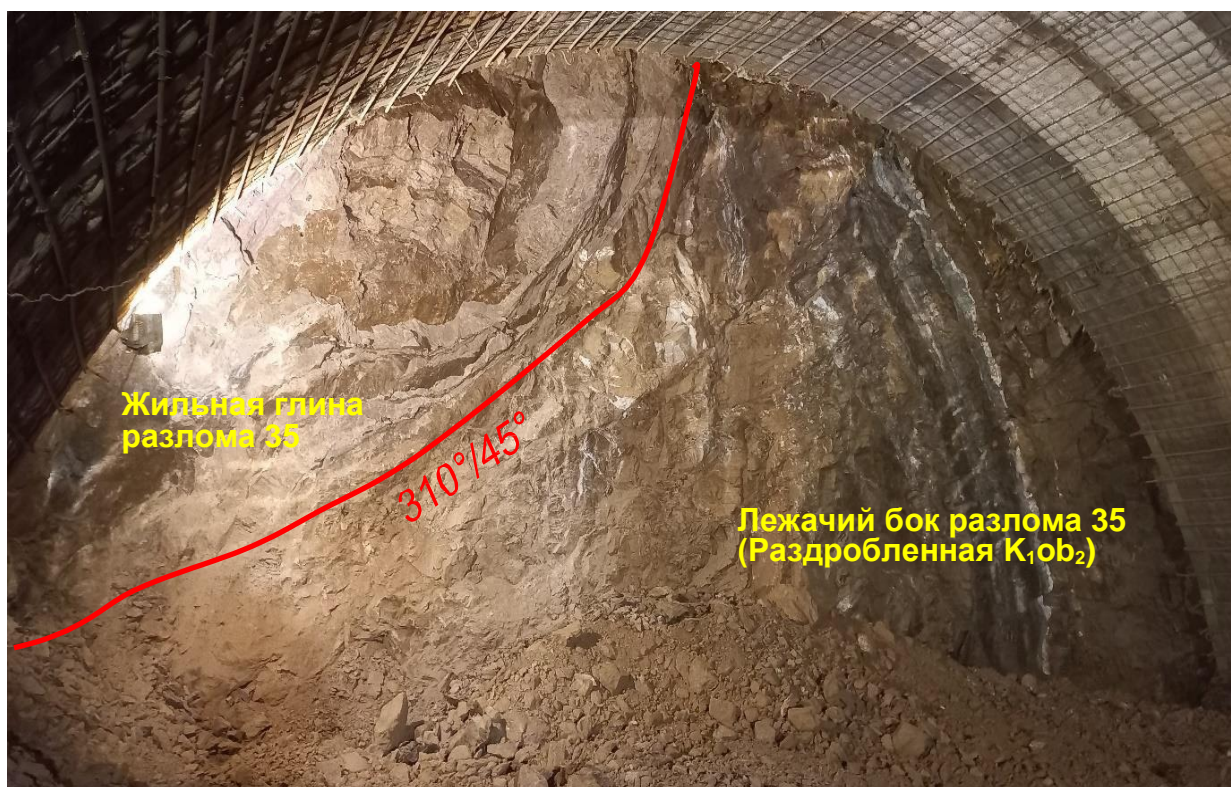
Рисунок 2.22: Зона разлома 35 материалы глины, алевролит и песок. Красные линии показывают границу лежащего бока разлома №35 в тоннеле СТ4-В
