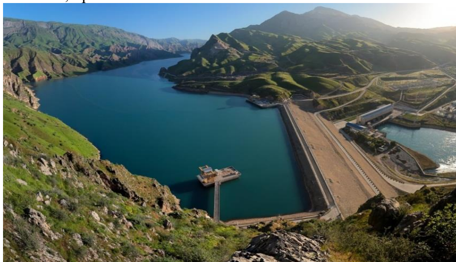
Рис. 3.11. Гидроузел Сангтудинской ГЭС-1
