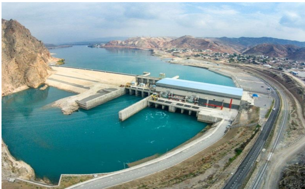
Рис. 3.12. Гидроузел Сангтудинской ГЭС-2 ( https://www.mewr.tj/?page_id=739 )
