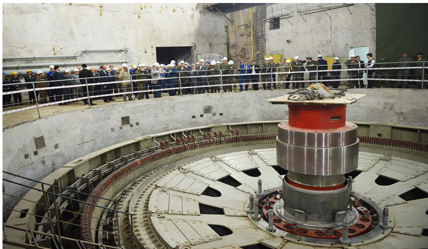
Рис. 4.11. Монтаж гидроагрегата Рогунской ГЭС
