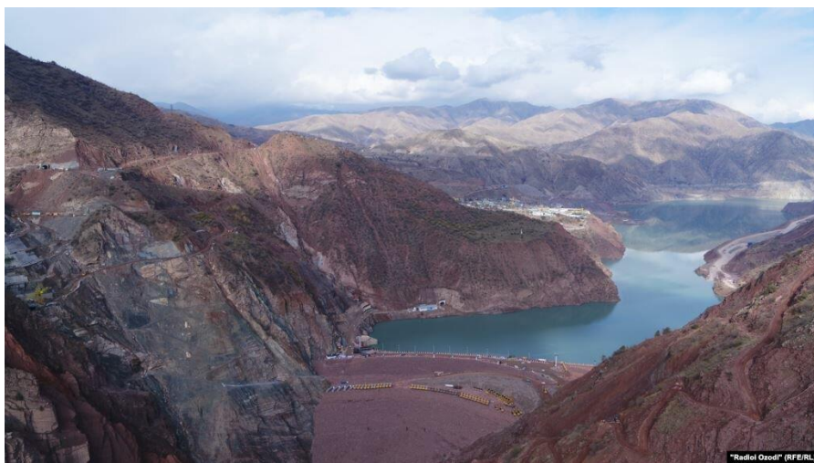
Рис. 4.9. Строительство плотины первой очереди Рогунской ГЭС
