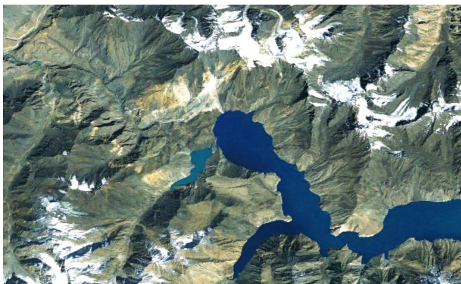
Рис. 3.5. Завальная плотина «Усой» Сарезского озера. Спутниковый снимок западной части Сарезского озера.
