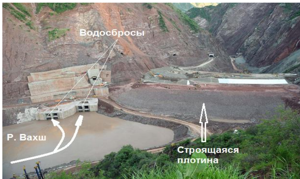
Рис. 3.8. Строящийся Рогунский гидроузел. ( https://www.mewr.tj/?page_id=739 )
